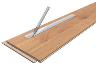
Skær igennem laklaget i fugerne rundt om staven. Brug en lineal.
